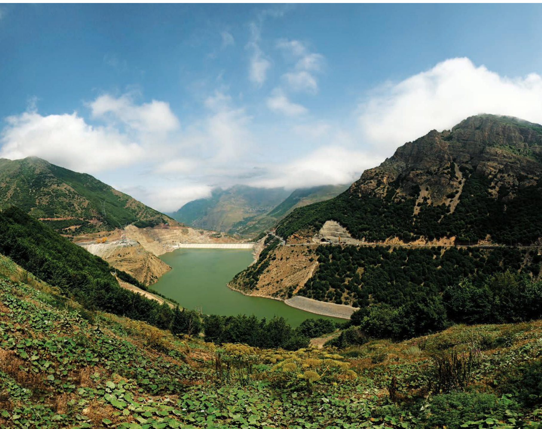
مشروع السد السفلى و العلوي و الهياكل المرتبطة بتصميم السد و محطة مضخة - ادخارية سياه بيشه (منجز)
