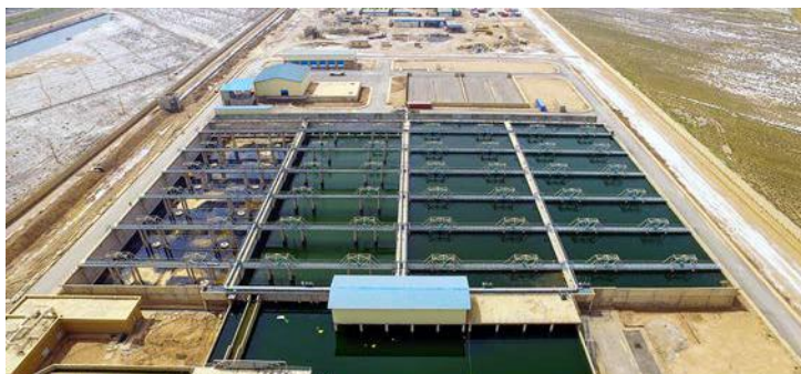
مصفاة الصرف الصحي شرق اهواز (منجز)
