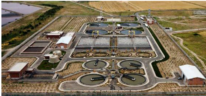
مصفاة الصرف الصحي التيمور مشهد (منجز)
