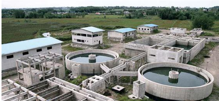
مصفاة الصرف الصحي بندر انزلي ( قيد التنفيذ)
