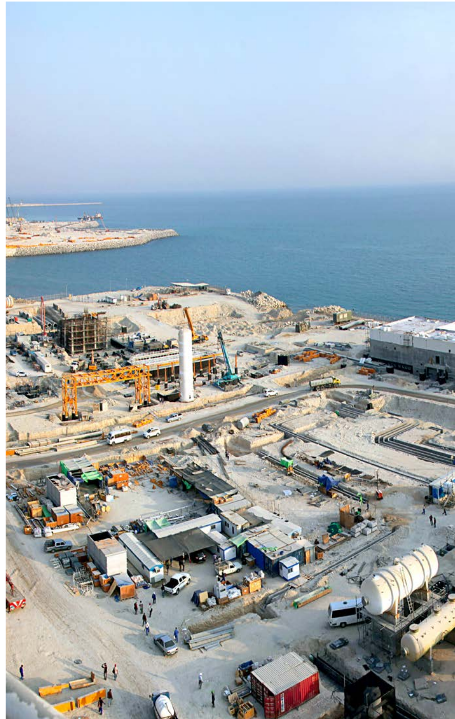
توسيع ساحة الغاز ۱۲ بارس جنوبی منشآت الشواطئ لمعالجة السوائل و المنشآت الجانبية -ای بی سی (منجز) EPC2
