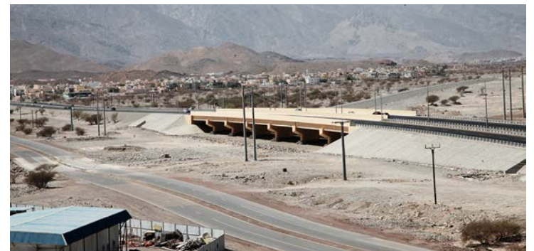
تأسيس الجسر على مسيل بنى سوق فى ايلة رشتاق -عمان (منجز)
