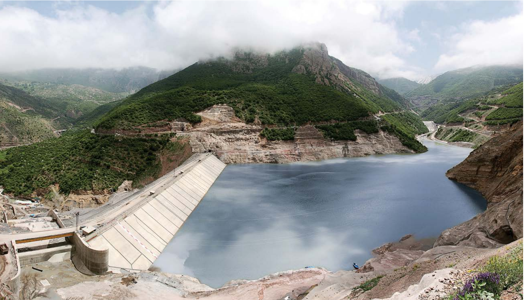
مشروع السد السفلي و العلياء و الهياكل المرتبطة بتصميم السد و محطة مضخة - ادخارية سياه بيشه (منجز)
