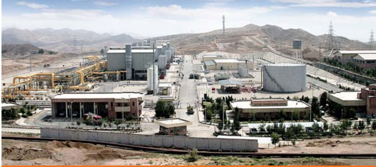
مشروع حقن غاز آغاچاری (منجز)
