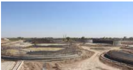
■ مشروع مصفاة وشبكة نقل المياه — الناصرية
