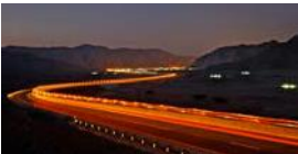
■ إنشاء جسر على طريق بني سوق في ولاية رستاق
