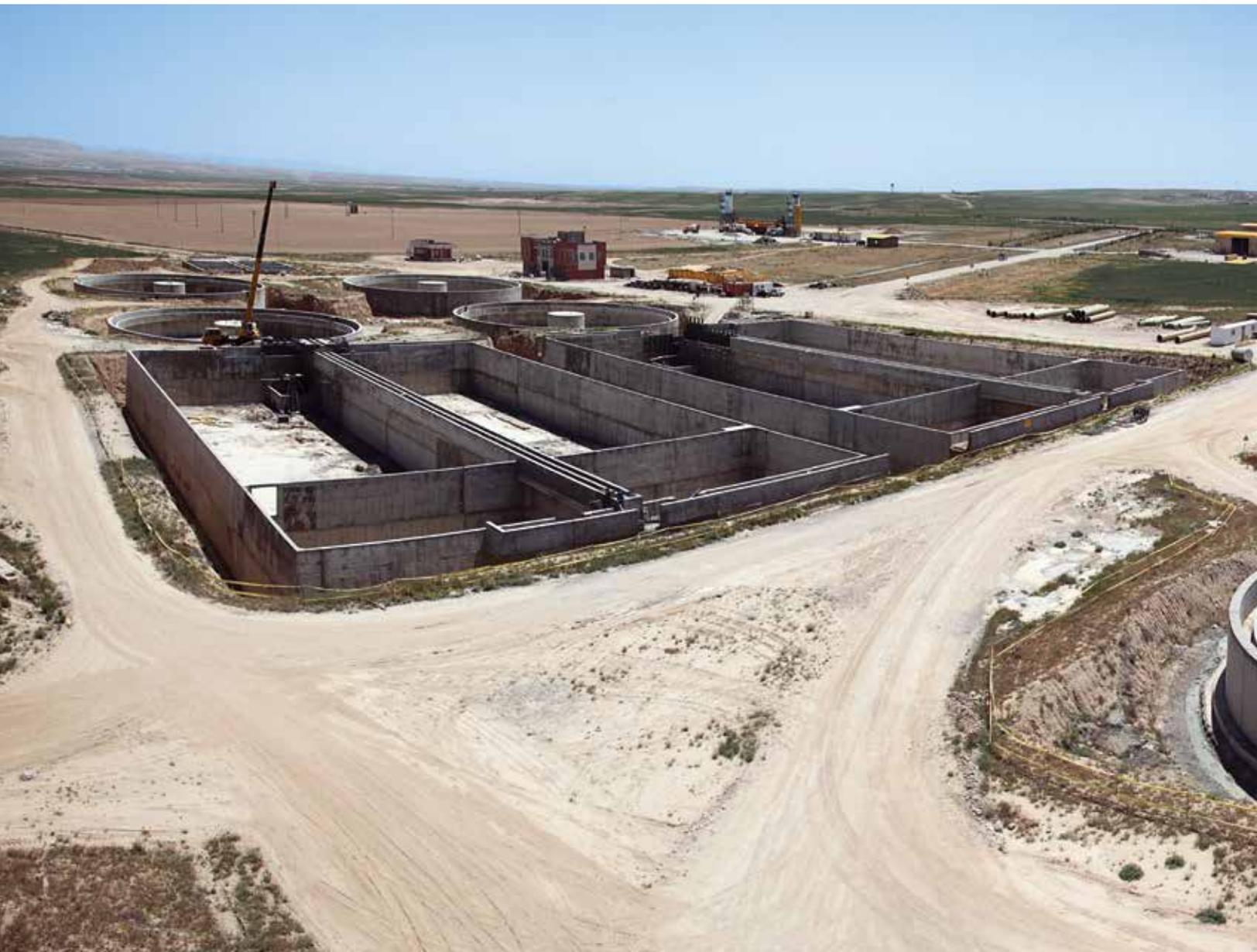
procédé MLE ou Modified Ludzack-Ettinger; les unités principales consistent en les filtres pour retenir des déchets et des particules solides, les bassins de décantation en amont, le réservoir à aération, les bassins à décantation en aval, les unités de boue, les bâtiments de contrôle, l'entrepôt, l'unité de réparation et le gardiennage. Ce projet est défini selon les critères suivants:
