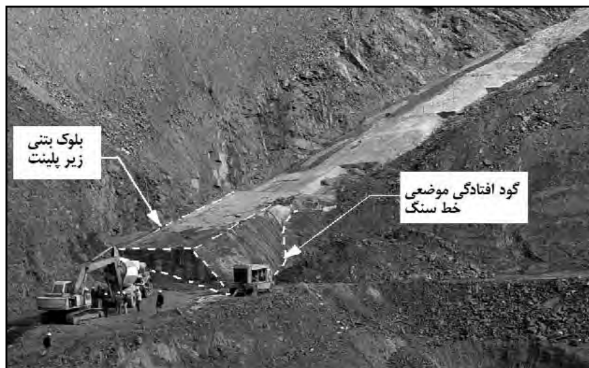
شکل ۱۱- نمایی از بلوک زیر پلینت درزها
